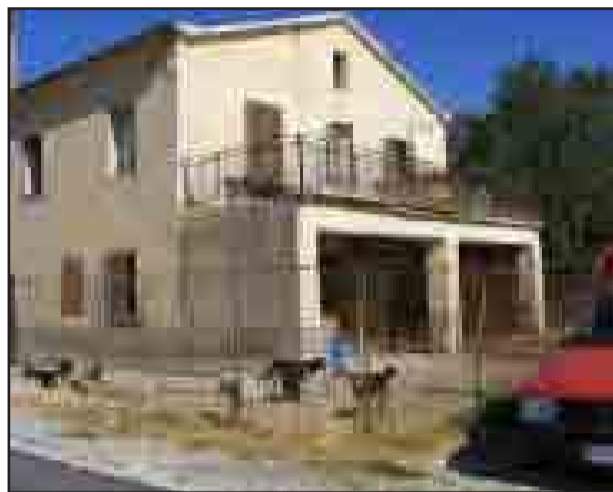
La struttura di contrada Castel di Croce
